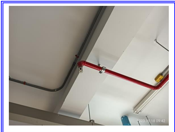
รูปที่ 3-38 ระบบหัวจ่ายน้ำดับเพลิงอัตโนมัติ
