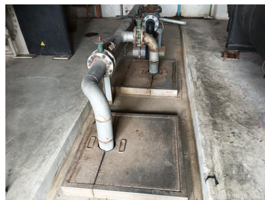
รูปที่ 3-17 ฝาทรงเก็บน้ำใต้ดิน
