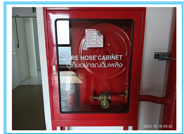
รูปที่ 2.3.14 ตู้เก็บสายฉีดน้ำดับเพลิงพร้อมอุปกรณ์
