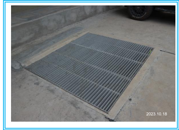
รูปที่ 2.3.4 บ่อพักน้ำสุดท้ายก่อนออกนอกโครงการ
