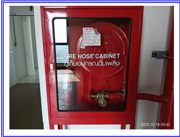
รูปที่ 3-36 ตู้เก็บสายฉีดน้ำดับเพลิงพร้อมอุปกรณ์
