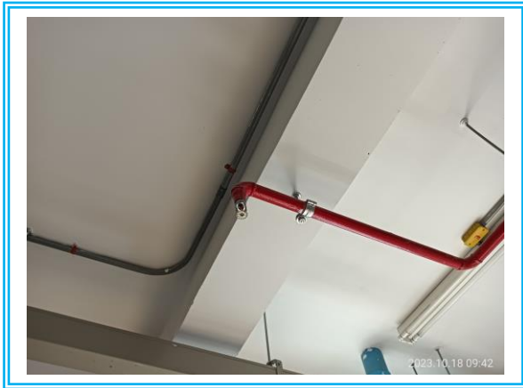
รูปที่ 2.3.15 ระบบหัวกระจายน้ำดับเพลิงอัตโนมัติ
