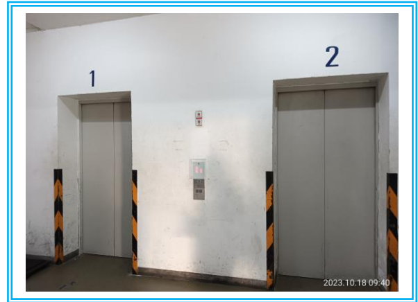
รูปที่ 2.3.16 ลิฟต์ดับเพลิง
