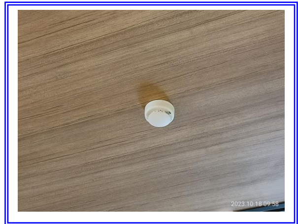
รูปที่ 3-33 เครื่องตรวจจับควัน
