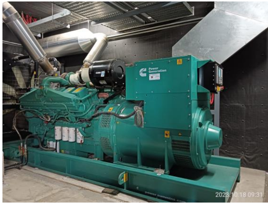
รูปที่ 3-26 อุปกรณ์เครื่องสำรองไฟฟ้า
