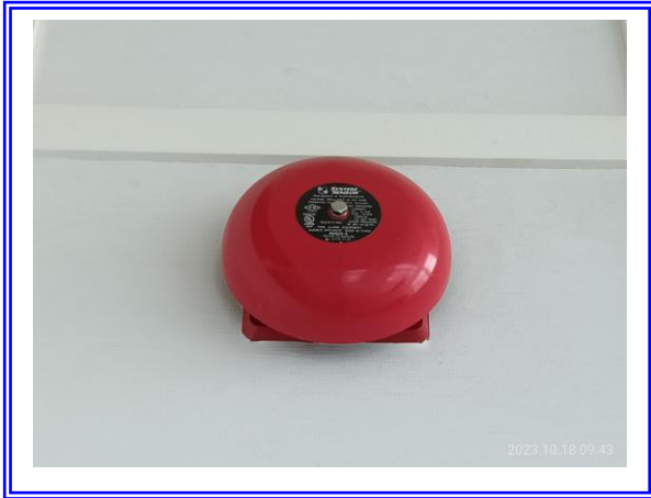
รูปที่ 3-31 สัญญาณกริ่ง
