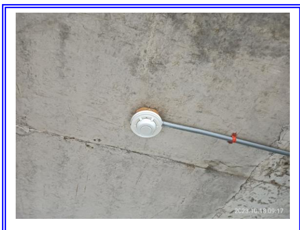
รูปที่ 3-34 เครื่องตรวจจับความร้อน
