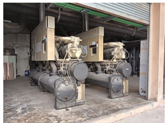
รูปที่ 3-30 ระบบระบายความร้อนด้วยน้ำ แบบสกรู
